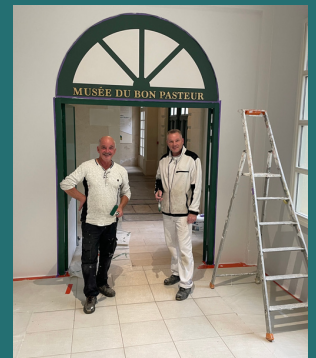
Christophe et Didier, les peintres du centre administratif de la Province Europe BFMN en pleine activité de peinture : porte verte, murs de l'entrée.
